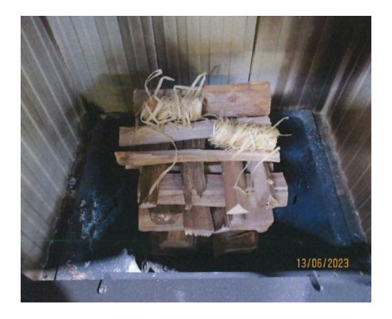
Die Anzündhilfe mit Hilfe eines langen Zündholzes oder einem Stabfeuerzeug entzünden. Das Anzünden von oben minimiert die Rauchbildung in der Anzündphase und unterstützt somit eine möglichst schadstoffarme Verbrennung.
