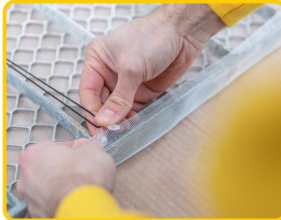
Lichtschachtabdeckung umdrehen, Gewebe mit den Befestigungsbändern verbinden.
