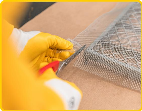
Ecken einschneiden und überschüssiges Gewebe entfernen.
