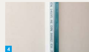
4. Trenn-Fix andrücken und glatt streichen
