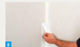
8. Überstehenden Streifen abziehen
