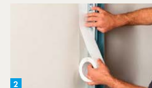
2. Trenn-Fix neben Profil kleben
