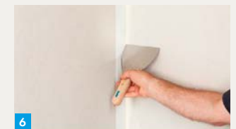
6. Fuge mit Uniflott verspachteln
