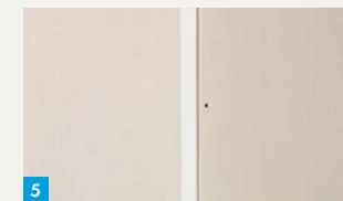
5. Gipsplatten mit ca. 5 mm Abstand montieren
