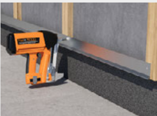
Befestigung des Sockel-Lüftungsprofil.
