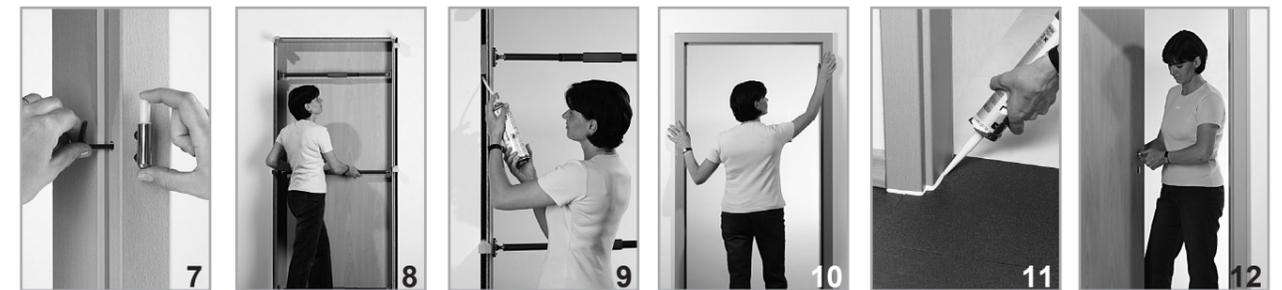
Stecken Sie die Bandunterteile ein und fixieren Sie diese mit dem mitgelieferten Inbusschlüssel. Eventuell die Inbusschraube vor dem Einstecken etwas lösen.
